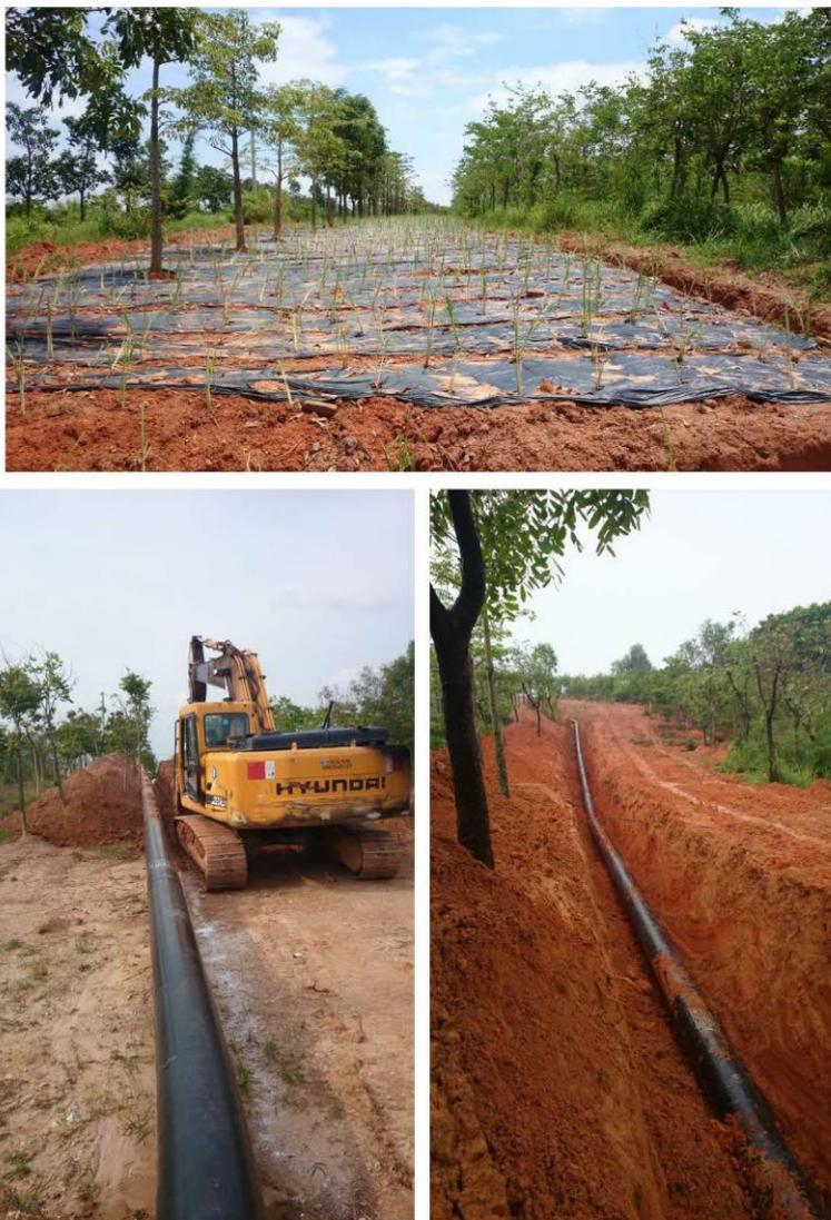
附图2 输油管线
