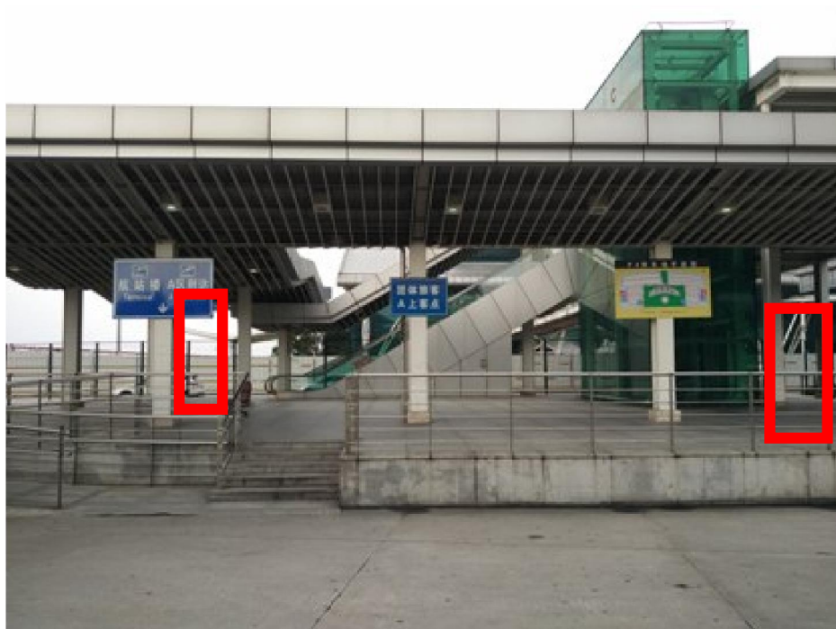
东侧过街天桥下
