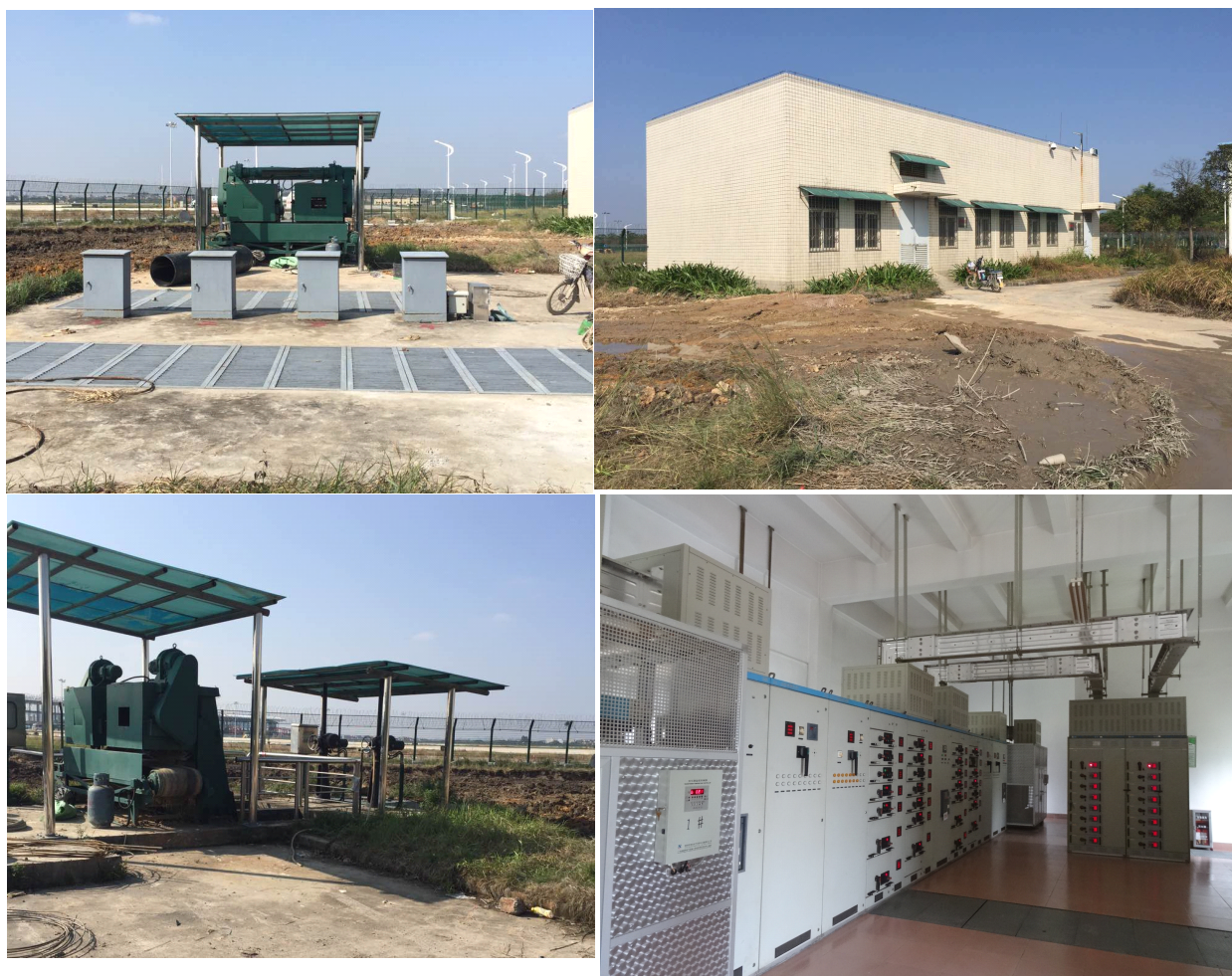
图 2 项目场址现状图
